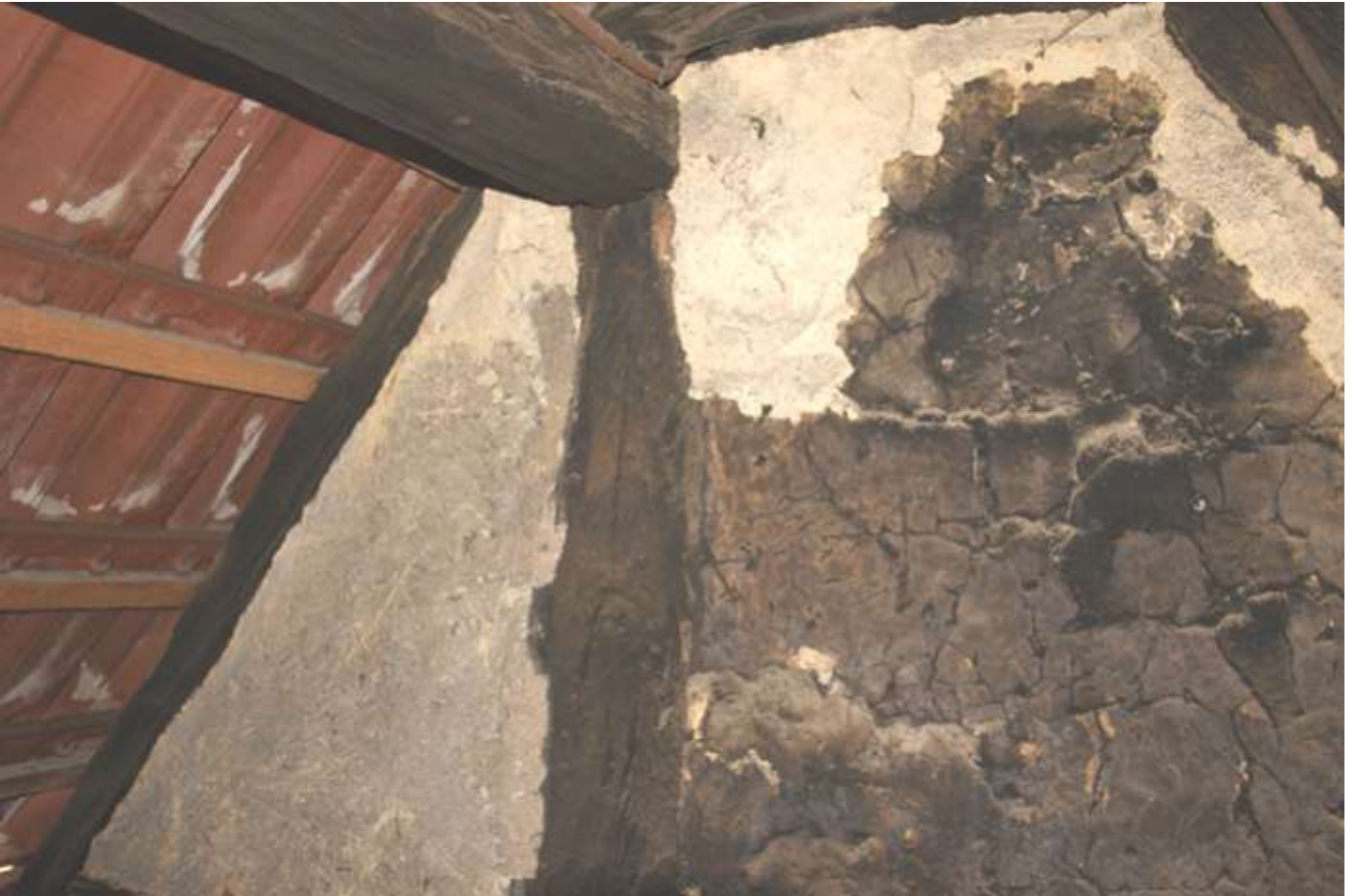
Figures 114 et 115. Pignon Est, vue de l'intérieur sur les deux poteaux porteurs de panne. On voit que l'environnement en torchis de ces derniers a été remanié lors d'une réparation lourde de la charpente
