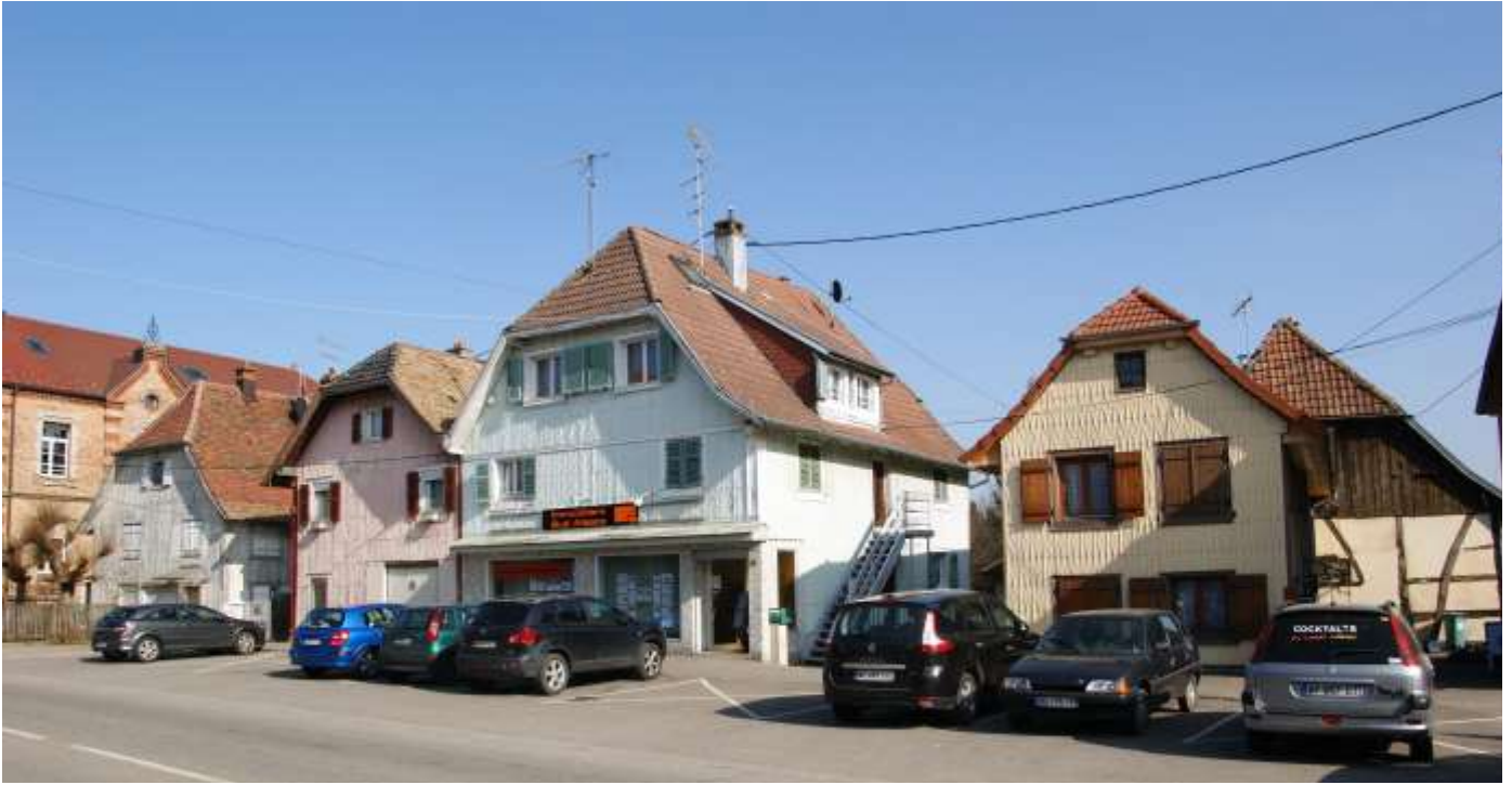
Figure 56. A gauche pignon du n° 20 Place de l'Hôtel-de-Ville, à droite n° 12. Noter que tous les pignons sont recouverts d'un bardage en zinc les protégeant des vents et pluies dominants.. La position de cette série de quatre bâtiments est inchangée par rapport au plan de 1775.
