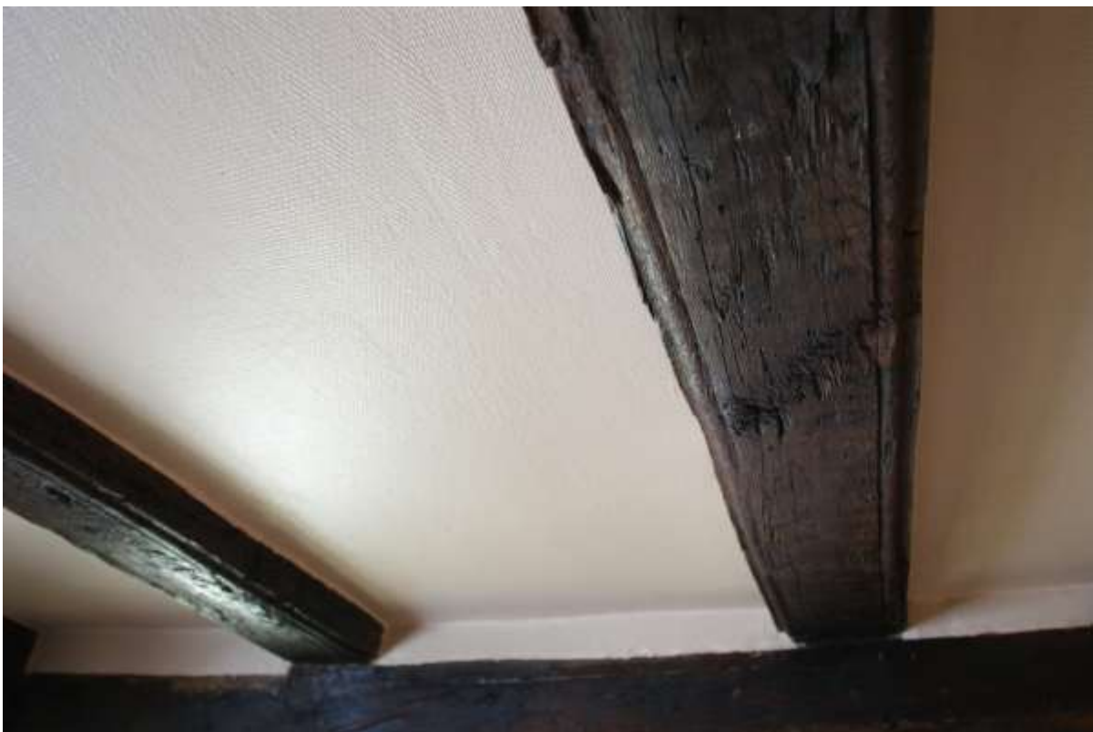
Figure 92. Solivage du plafond de la Stube
