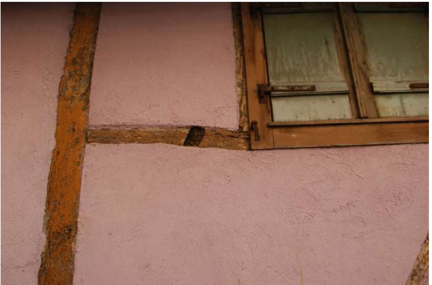
Figures 67 et 68. Détails de la façade nord: assemblage à mi-bois.
