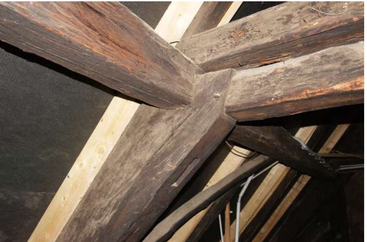
Figure 63. Détail de ferme montrant la mortaise correspondant à l'aiselier disparu
