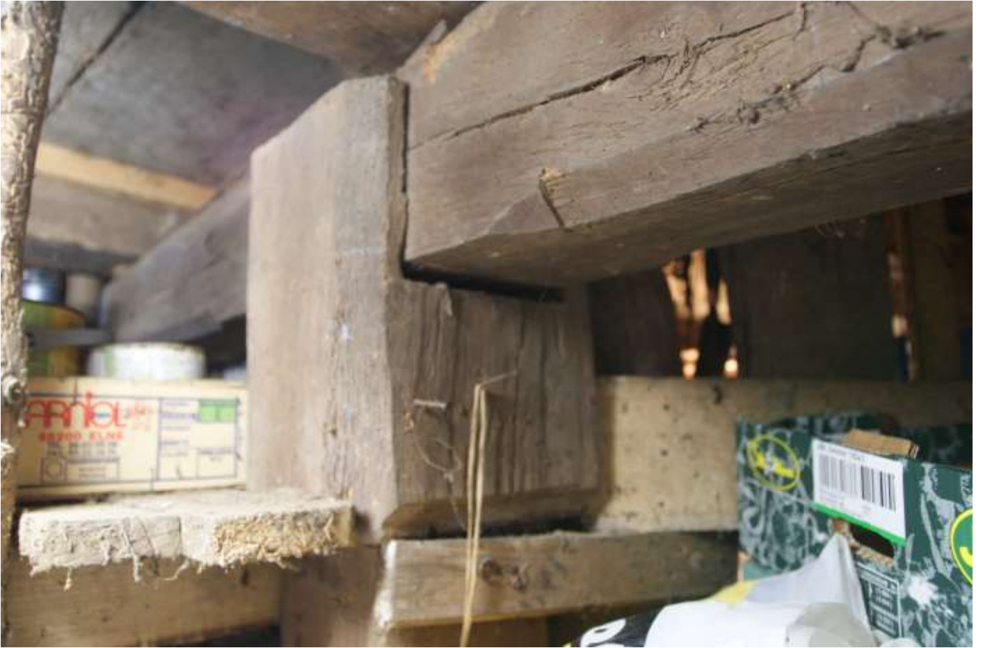
Figure 88. Pilier de soutènement de la sous-poutre de la cave
