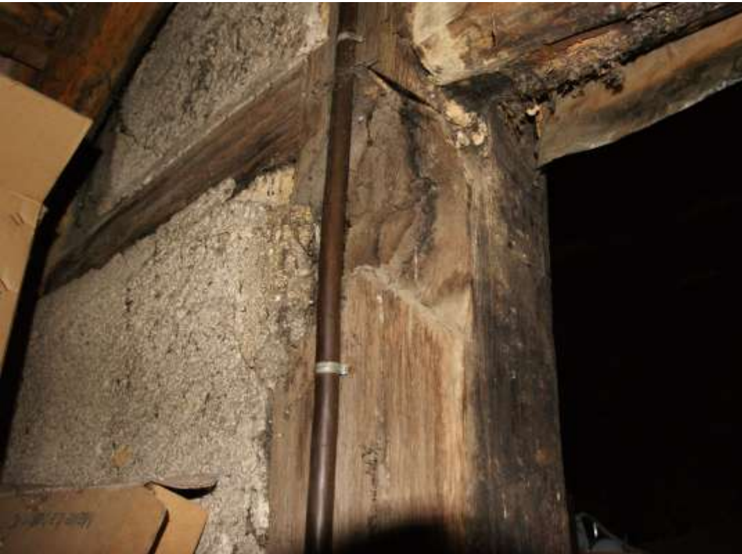
Figure 72. Mi-bois des contrefiches du poteau central sur pignon arrière (détail caché par l'appentis cf figures 69 et 70)
