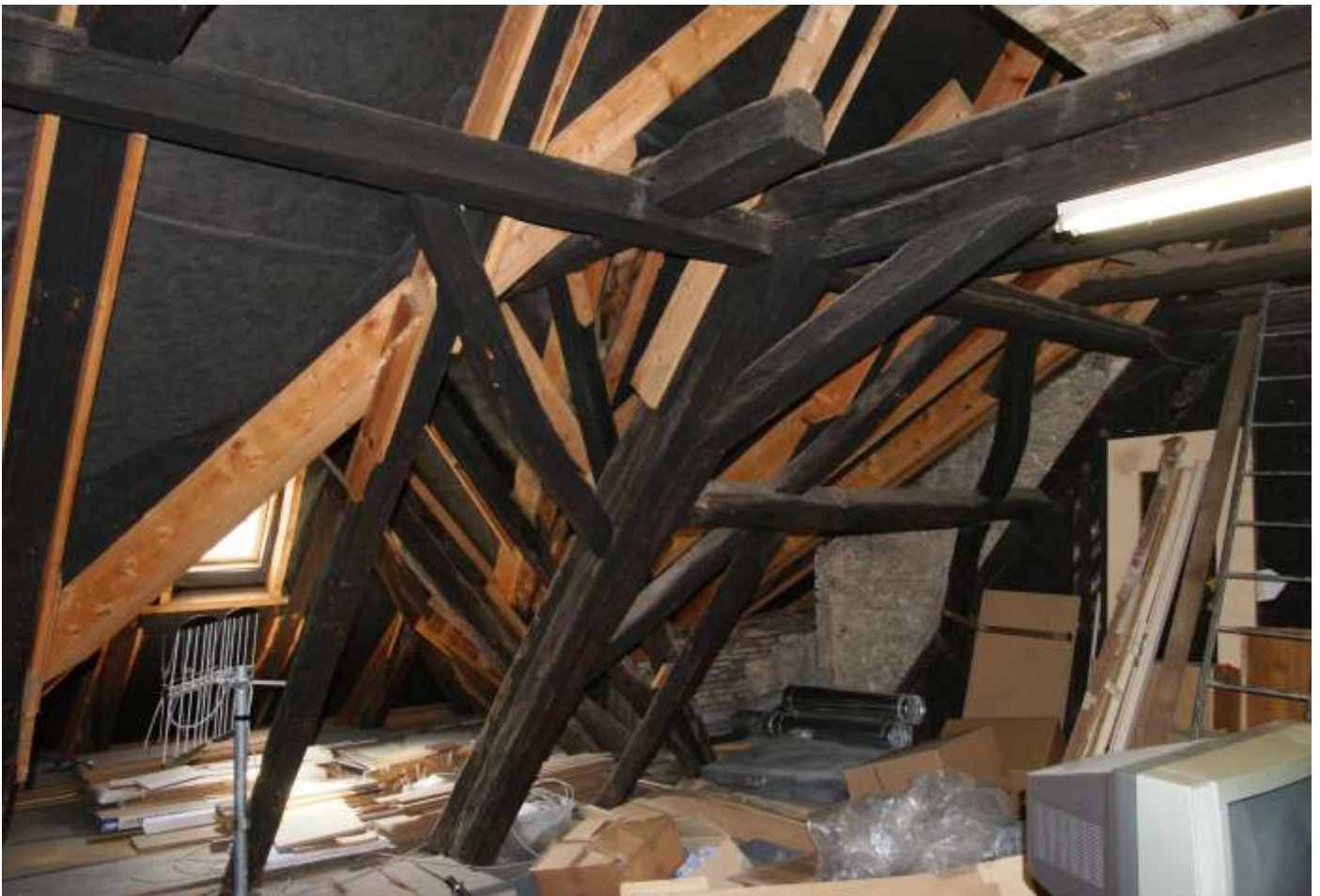
Figure 48. Pan sud de la charpente, première ferme maîtresse à l'endroit du raccord avec l'adjonction sur la rue
