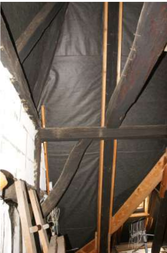
Figure 51. aisselier reliant le poteau et la panne sur pignon Est.
