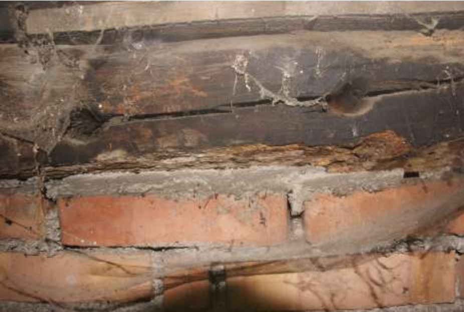
Figure 118. Percements dans l'appui de fenêtre des combles, pignon sur rue (intérieur)
