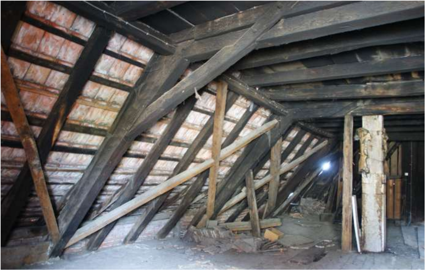
Figure 26. Pan sud, vu depuis le pignon Est.
