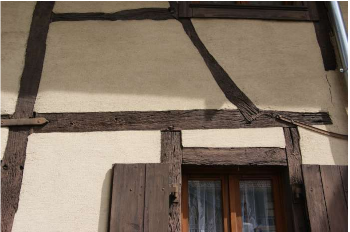
Figure 60. Détail de la façade sud
