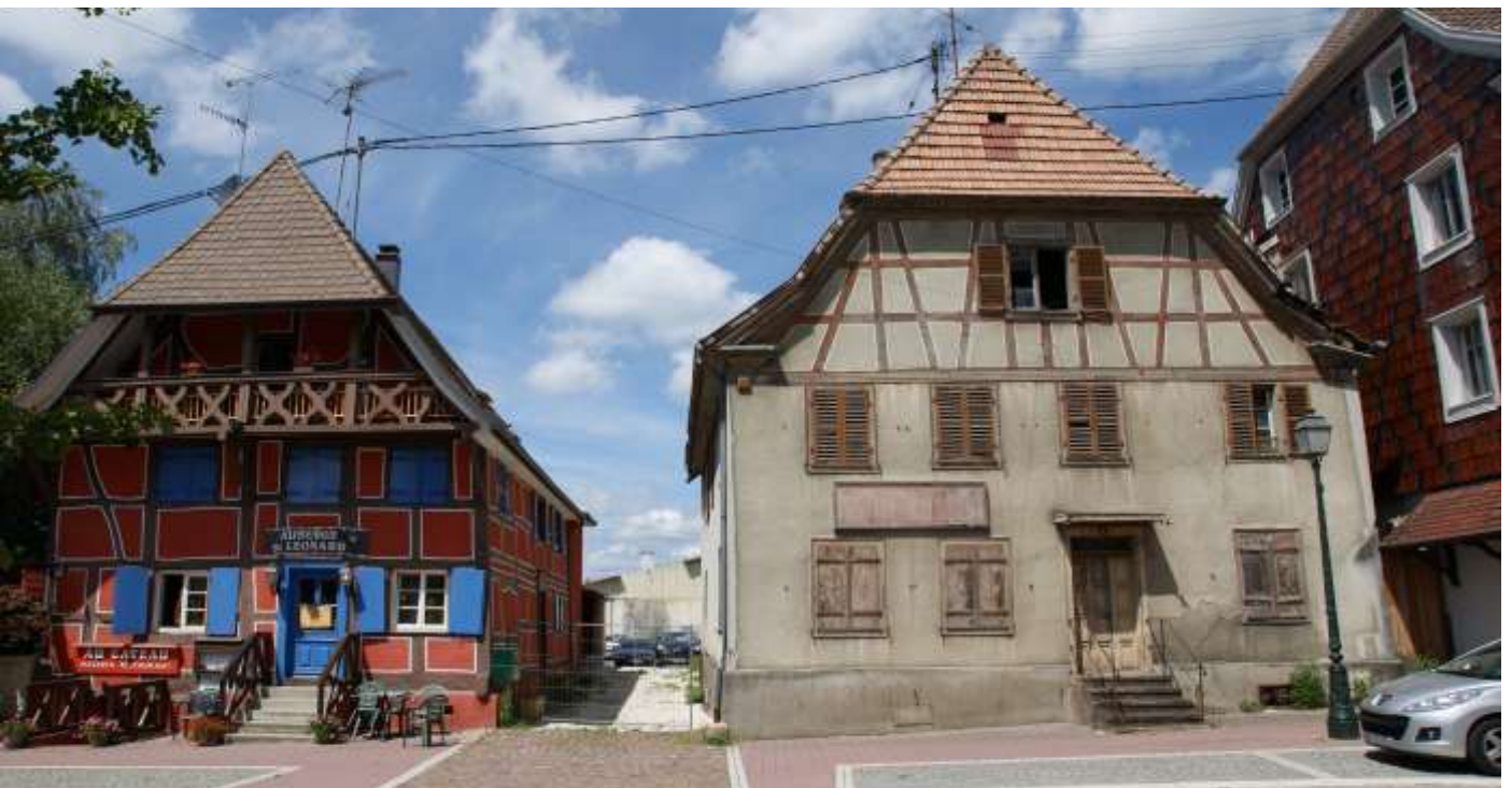
Figure 21. Pignons Est, de gauche à droite, des n° 6, 4 et 2 rue Saint-Léonard
