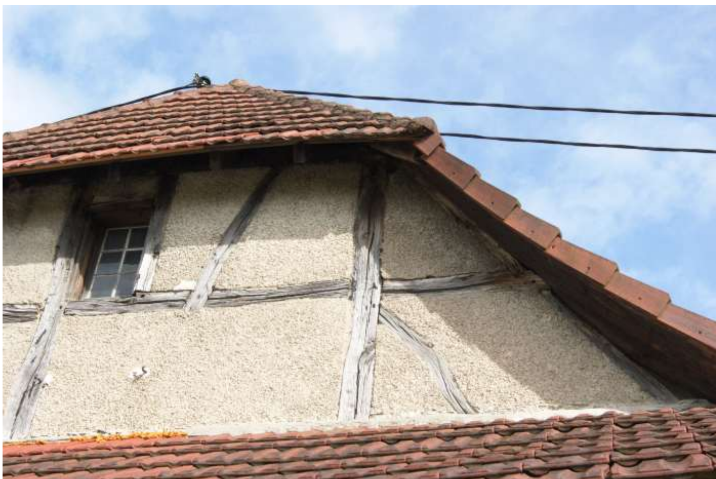
Figure 113. Détail du pignon arrière: assemblage de l'entretoise sur le chevron à mi-bois et queue d'aronde
