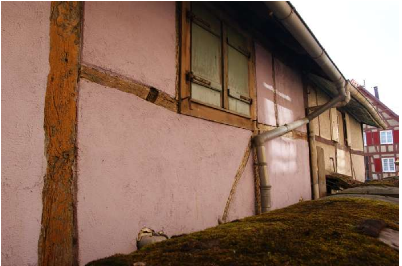
Figures 67 et 68. Détails de la façade nord: assemblage à mi-bois.
