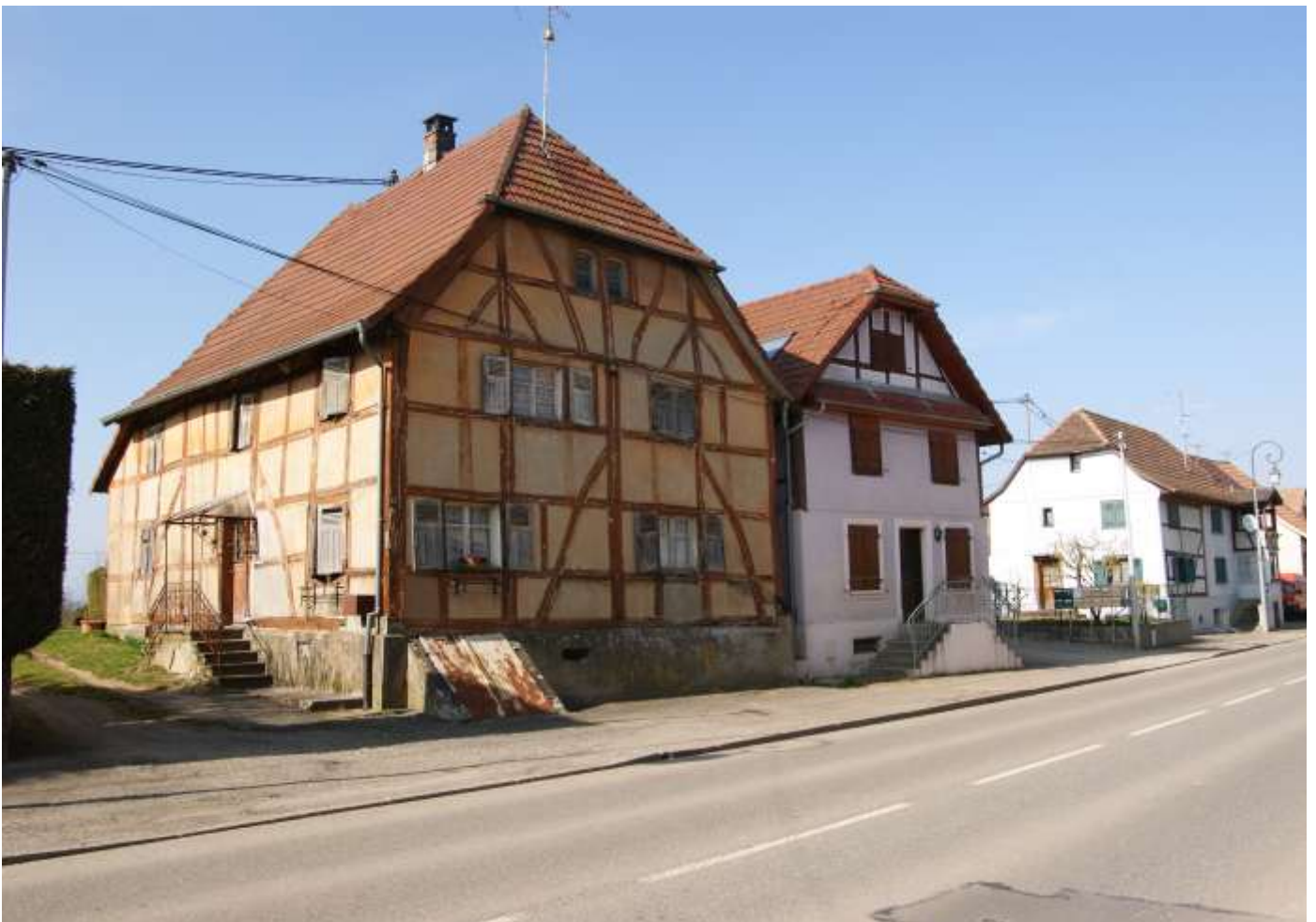
Figure 100. De gauche à droite, n° 23, n° 25 et n° 29 rue de Cernay: un ensemble homogène. Le n° 23 est la seule construction intégralement conservée, les deux autres ont été modifiées.
