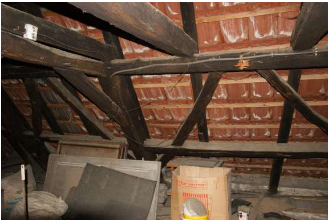
Figure 116. Ferme et contreventement
