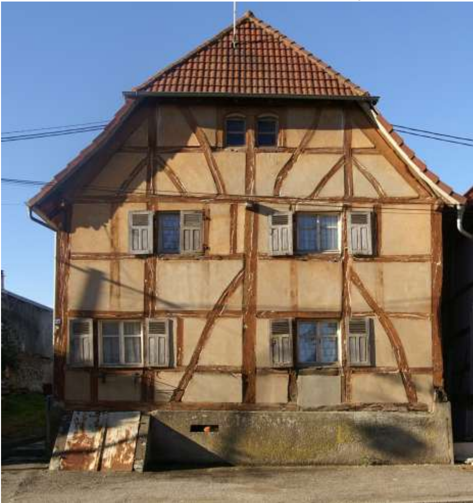
Figure 104. Pignon sur la rue (Est)
