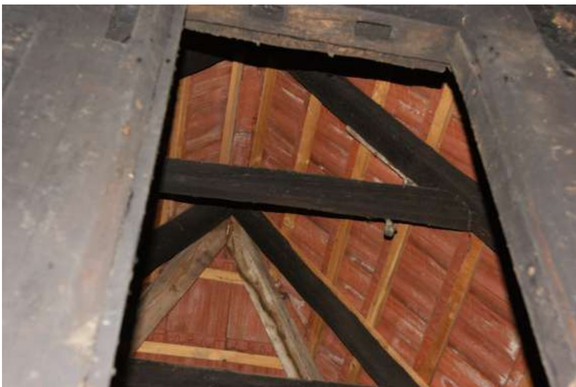
Figure 117. porte du local du deuxième étage des combles et deuxième étage de faux-entraits
