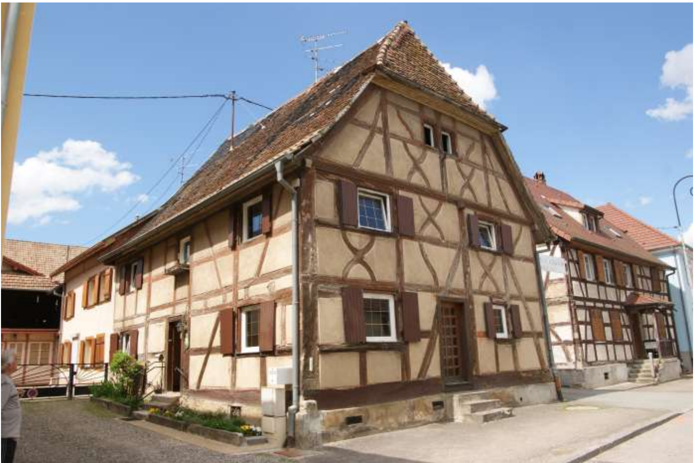
Figure 87. Pignon Est et façade sud
