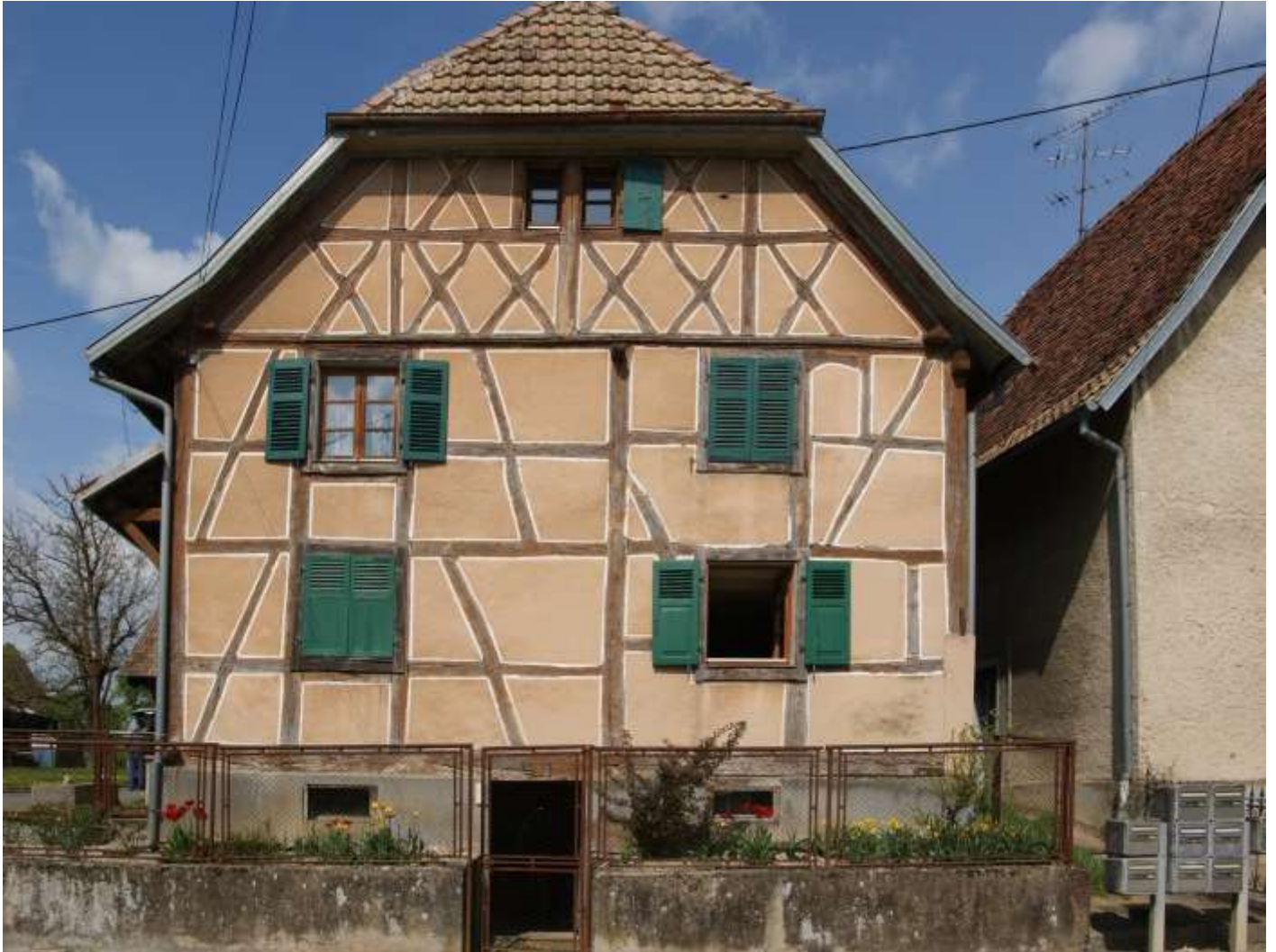
Figure 109. Wolfersdorf, maison datée 1564d. Pignon Est sur la rue, montrant les mêmes fenêtres de combles (et de Kammer d'étage) que les fenêtres des combles du n° 23 rue de Cernay. Noter que là aussi la façade d'entrée est au sud, ce qui implique le retournement de la maison voisine.
