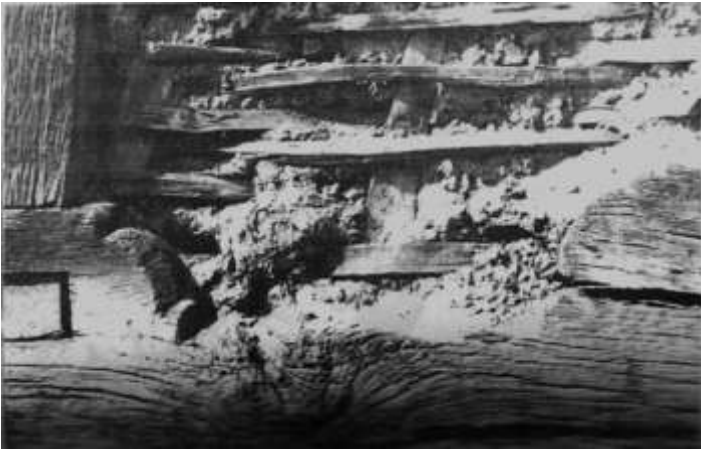
Figure 15. Linteau de porte gothique taillée dans la sablière (retournée) du 10 rue Saint-Léonard (20 sur le plan de 1775)
