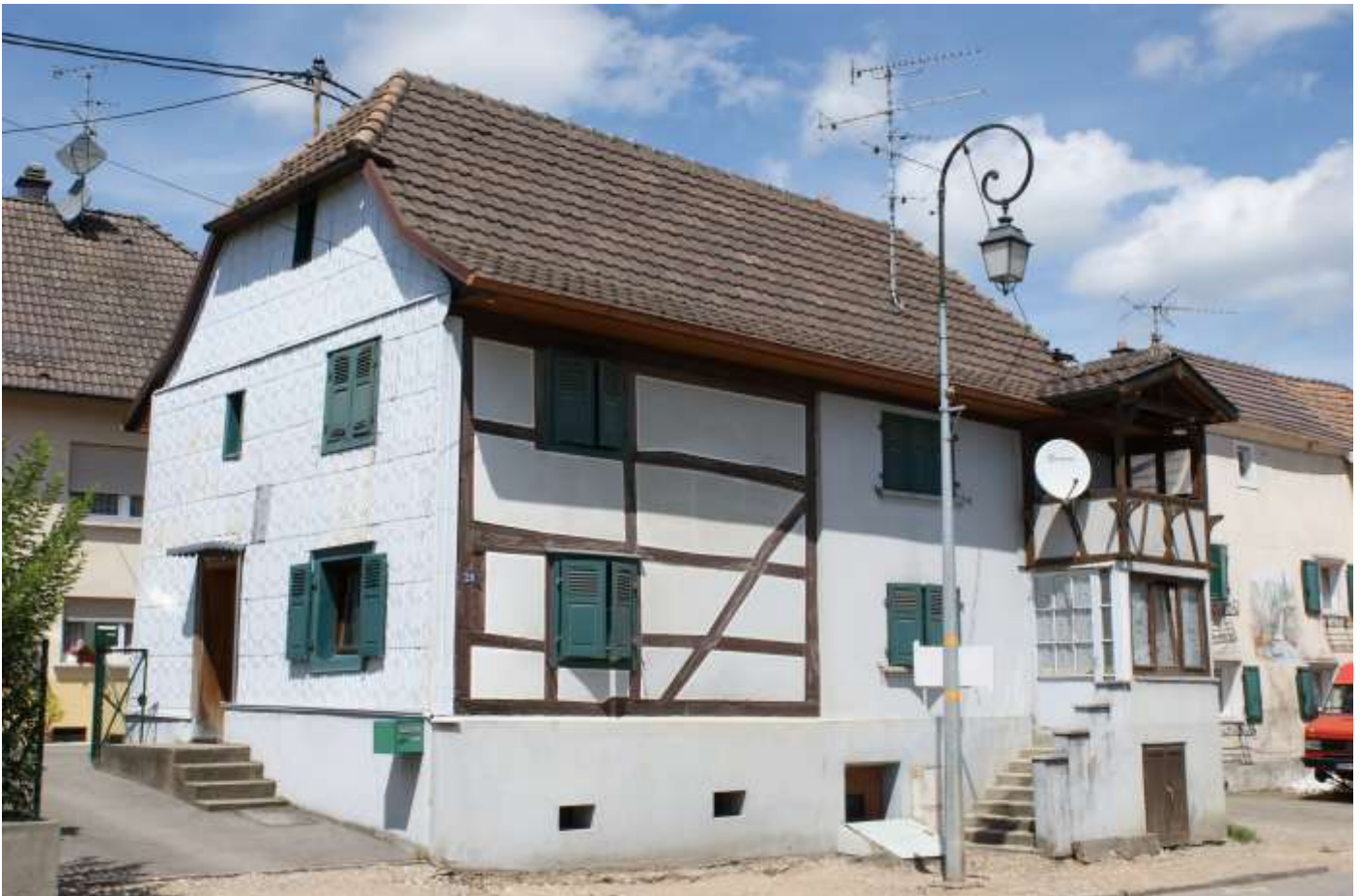
Figure 102. Façade sur rue (Est) du 29 rue de Cernay
