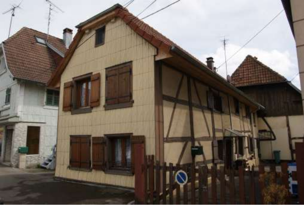
Figure 58. Pignon ouest sur rue et façade nord sur cour
