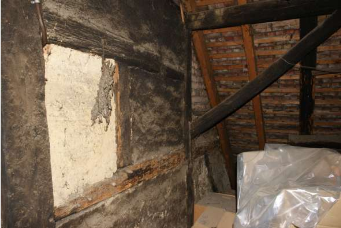
Figure 73. Pignon Est vu de l'intérieur avec aisselier et panne de la charpente d'origine en place.
