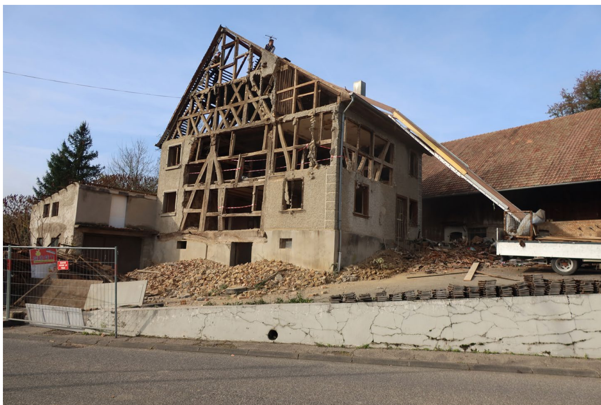
FIG. 2 : La maison 16 rue de Wentzwiller à Buschwiller mi-novembre 2022.
