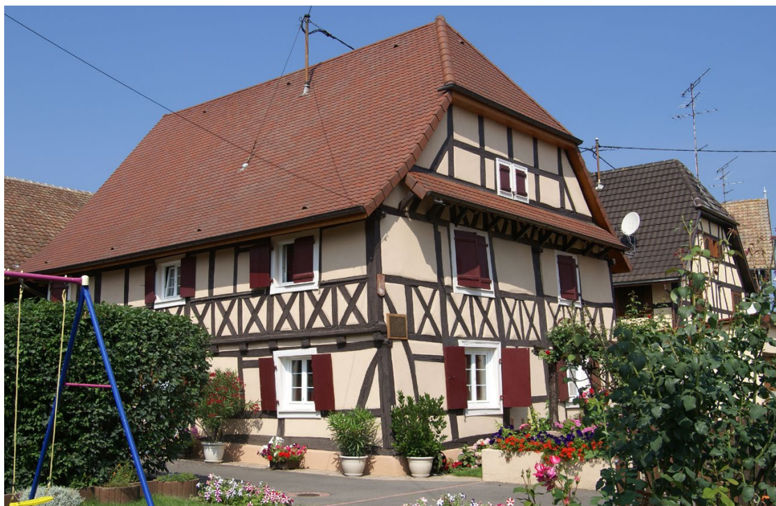
FIG. 9 : Reiningue, registre de croix de Saint-André courant sur le pignon sur rue et la façade sur cour, sur une maison combinant encorbellement et poteaux de fond datable des environs de 1530 par analogie avec des maisons de Heimbrun (v. 1535) et Wolfersdorf (1535).
