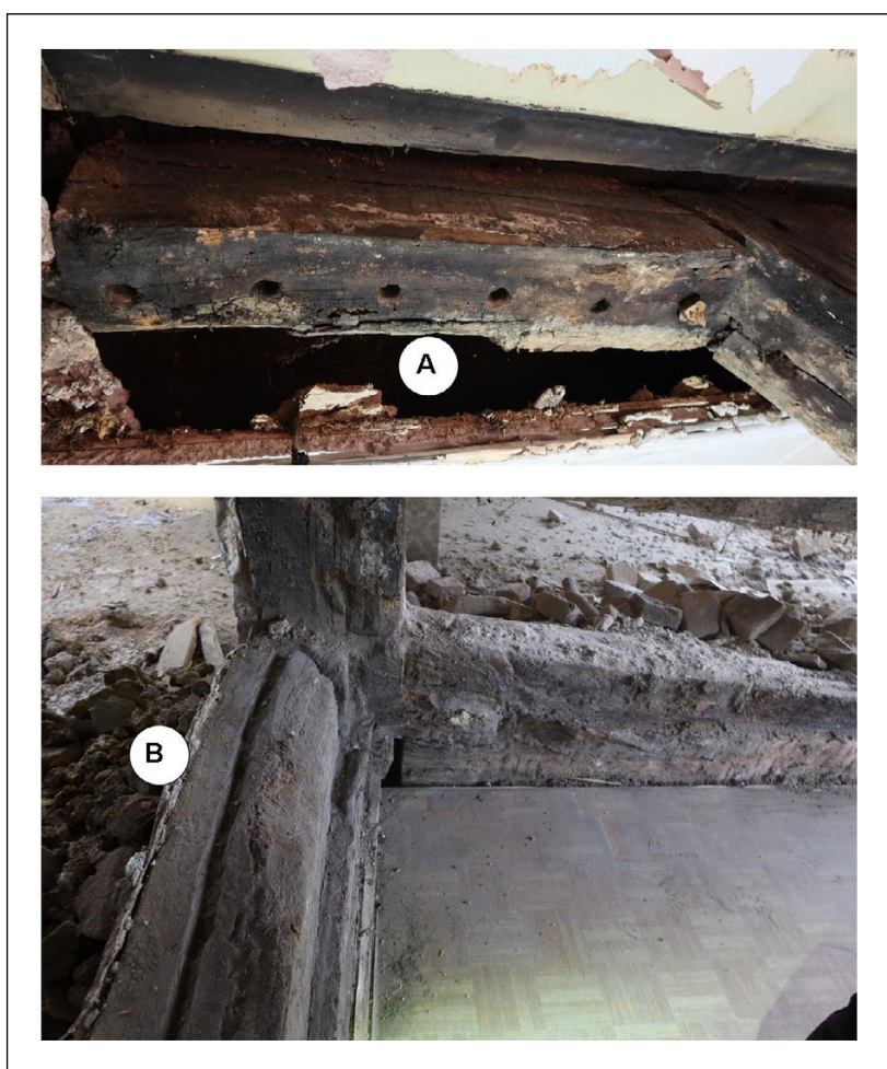
FIG. 25 : Buschwiller, 16 rue de Wentzwiller. Après enlèvement du torchis (Fig. 23) mise en évidence de la ligne de trous sur l'entretoise et de la rainure sur la sablière, dans lesquels sont logés les palançons.
