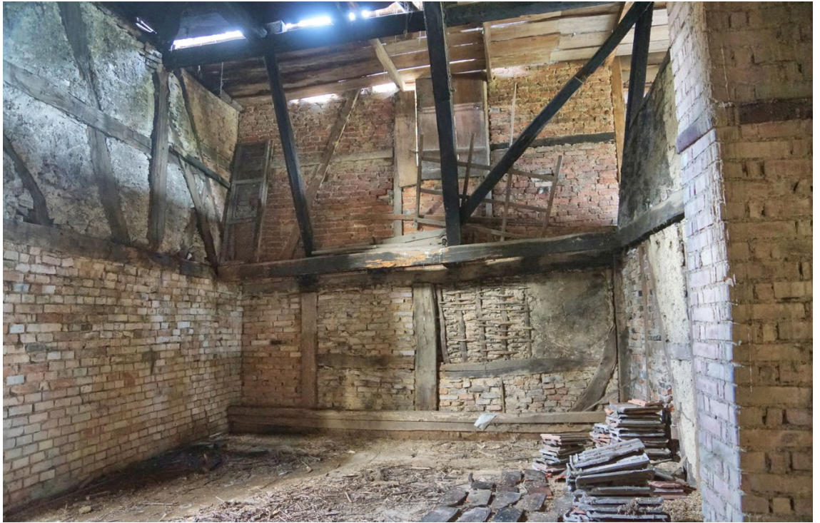
FIG. 16: Buschwiller, 16 rue de Wentzwiller. L'étage de la travée arrière est ouvert sous comble. L'épais poteau en bas au milieu est le montant d'une porte donnant primitivement sur la cour.
