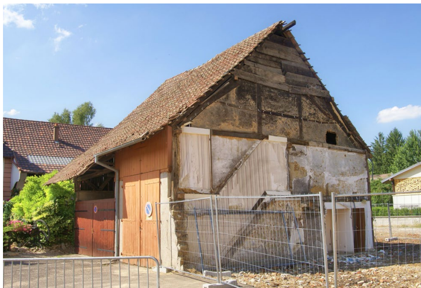
FIG. 18 : Retzwiler (1534 d). La démolition malencontreuse (2009) des travées avant et centrale de cette maison a néanmoins laissé subsister la travée arrière (correspondant à la porte de garage) et mis en évidence le cloison coupe-feu en torchis.
