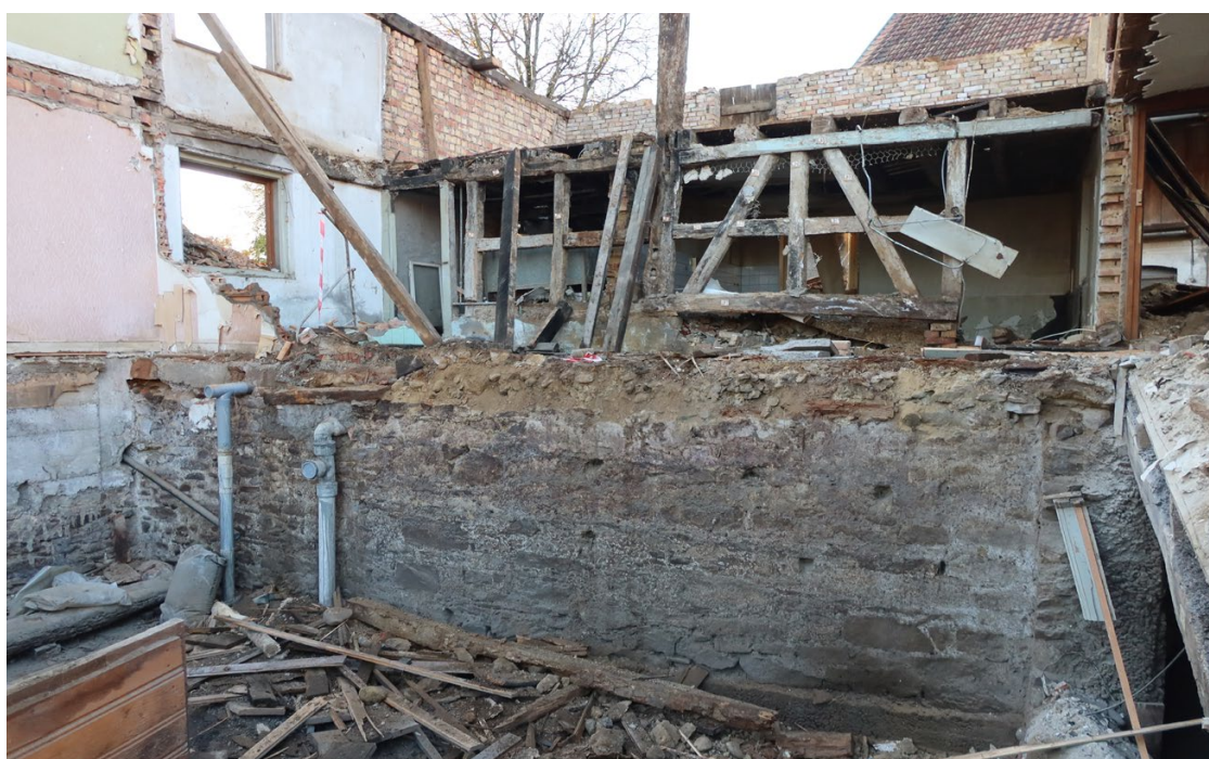
FIG. 10 : Buschwiller, 16 rue de Wentzwiller. Haut de poteau central sur pignon taillé en console, portant une croix en X. Assemblage de la sous-poutre longitudinale.
