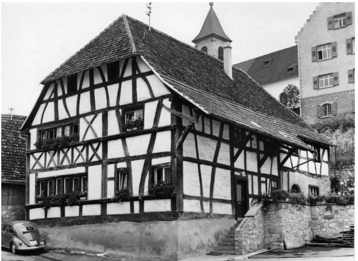
FIG. 17: Istein (Markgräflerland) 1580 (i?). La façade arrière a été inversée avec la façade d'entrée (la Stube soulignée par les registres de croix de Saint-André est à gauche). Elle est protégée par un large auvent similaire à celui de la maison de 1529 d à Schlierbach et de la maison de Buschwiller.
