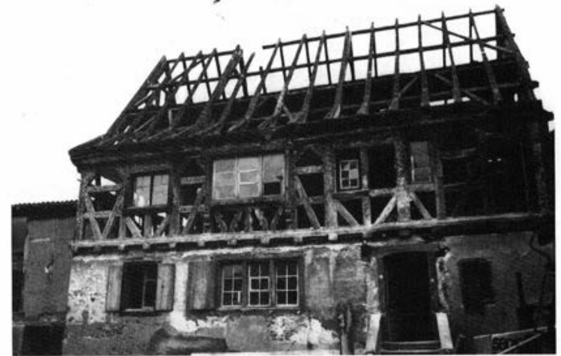
ci-dessus: façade sur cour durant le démontage, après arrachage du Schopf: cette dernière en haut, à droite met en évidence une porte extérieure à l'étage, ainsi que la destruction du pignon en colombages et son remplacement par un mur en pierres
