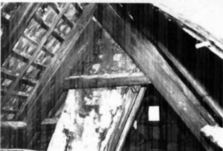
deuxième étage des combles in situ, cheminée desaxée pour rattraper le faîtage de la maison.
