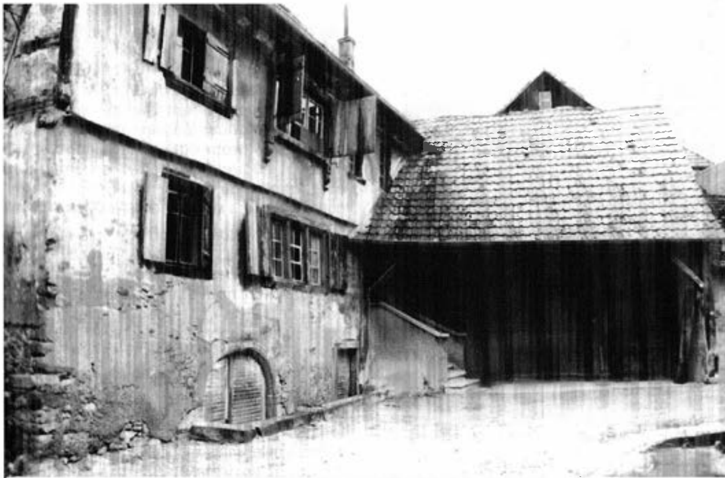
Façade sur cour, in situ, mettant en évidence l'encadrement en saillie de la fenêtre du 2ème étage. L'escalier est couvert par un schopf qui contenait le pressoir en bois jusqu'en 1923, date à laquelle il est remplacé par un pressoir dans la cave.
