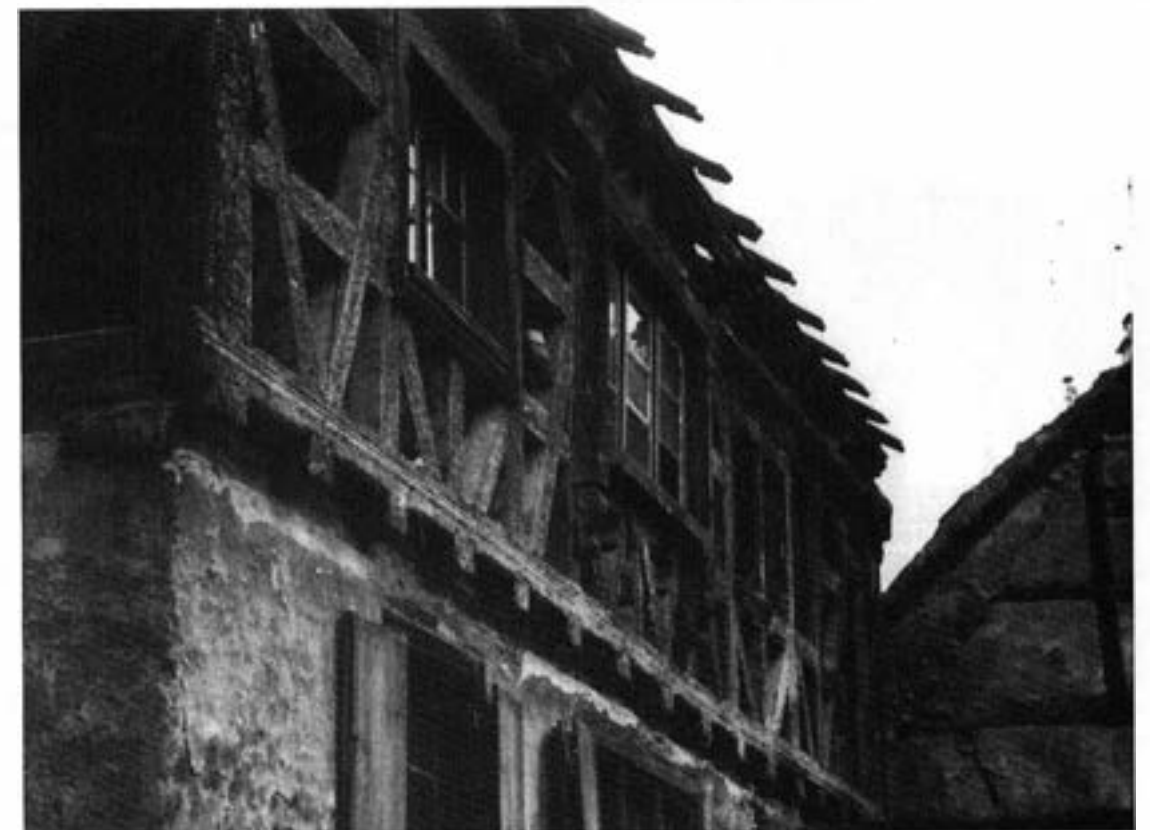
ci-dessous: fenêtre sculptée de l'étage, en cours de démontage
