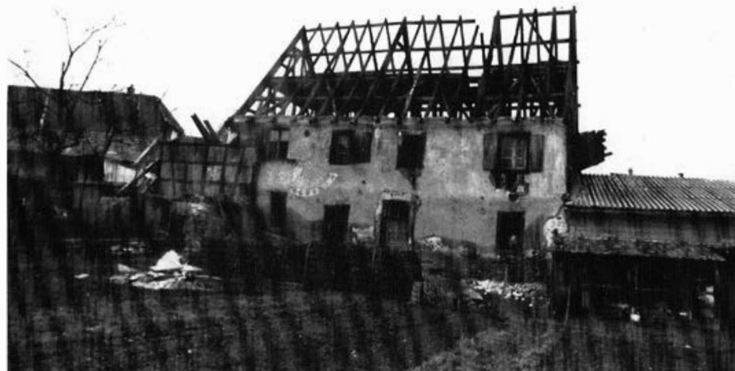
vue de la maison en cours de démontage, depuis le jardin.
