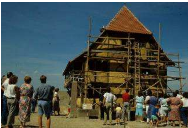
Figure 4 - La maison de Gommersdorf en cours de reconstruction à l'écomusée d'Alsace (1988)
